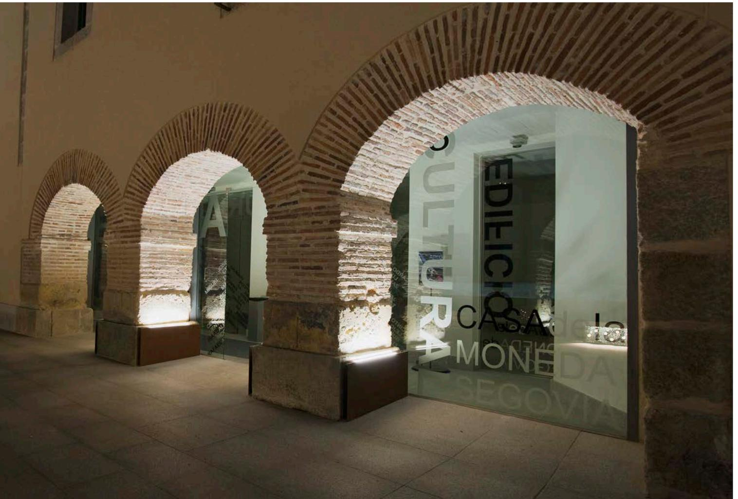
Estructura en forma de "h" de acero corten. En la parte superior dispone de un sistema para acoplar una luminaria lineal de ledes de 14,4 w/m 3000°IK, IP de 67 y difusor opal.
